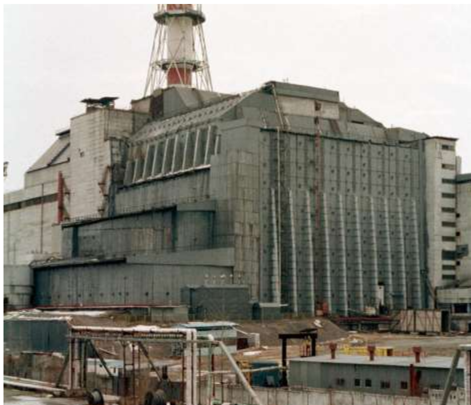
Саркофаг Чернобыльской атомной электростанции
